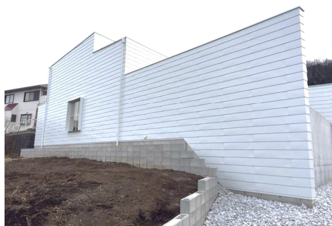
某物件 外壁写真
